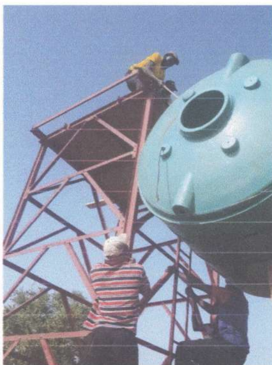
Maintely Montage du Château d'eau et borne fontaine
