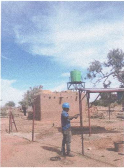
Mise en place de l'adduction de Yamel
