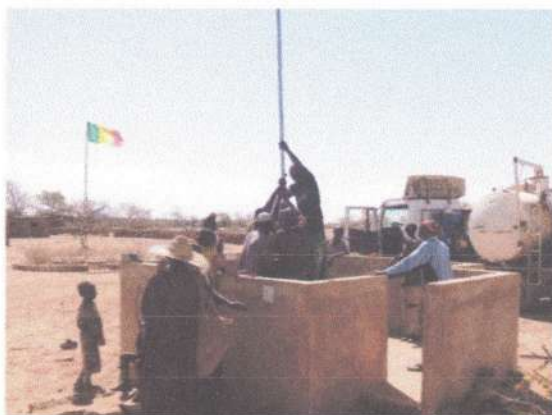
Nantaga : reprise du forage de l'école Les anciennes bornes fontaines du village seront aussi changées par ce modèle.
