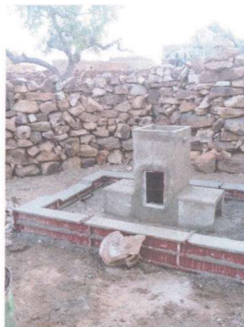
Diève déplacement du Château d'eau et constructions des nouvelles bornes fontaines
