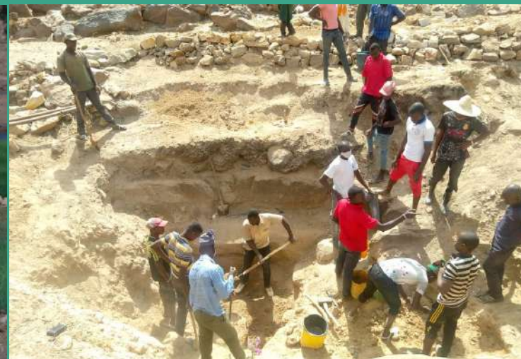
Le creusement des retenues d'eau
